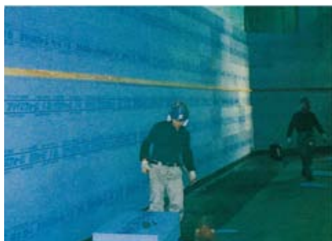
⑤断熱材を設置
