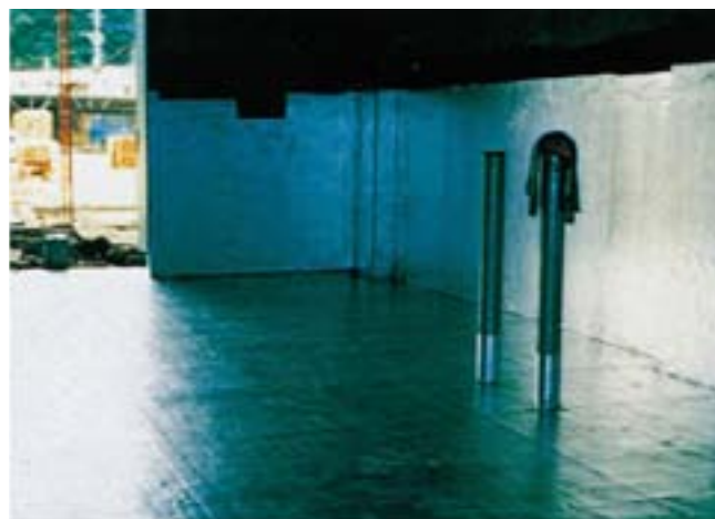
④トライシート底部、壁面施工完了
