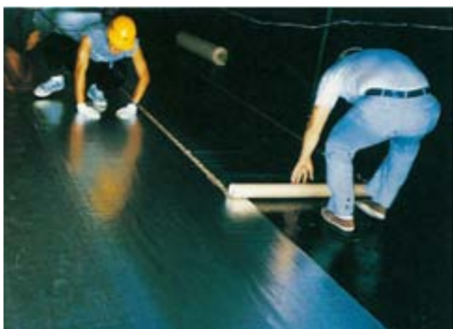
②底部にトライシートTR-10を敷設
