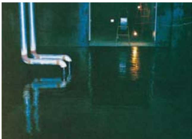
①プライマーを全面塗布
