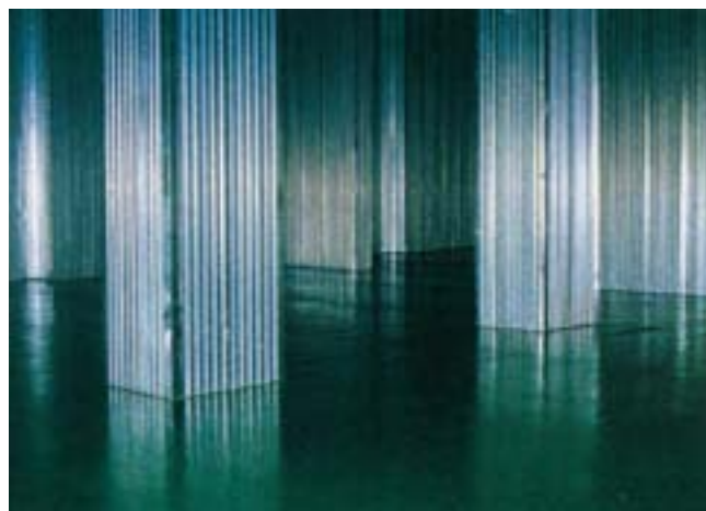
⑥仕上材を施して完成
