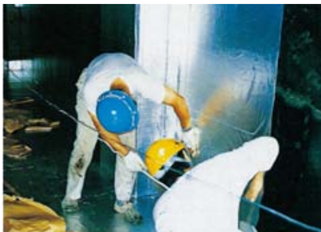
③壁面にトライシートTR-10を貼り付け
